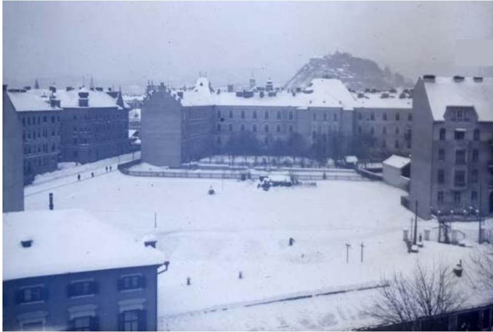
Rückansicht des Schulgebäudes. Der Zubau in der Pestalozzistraße wird 1968/69 fertiggestellt.
