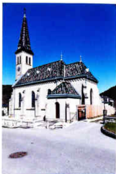
Kirche Weissenbach Betonbau an der Trüesting
