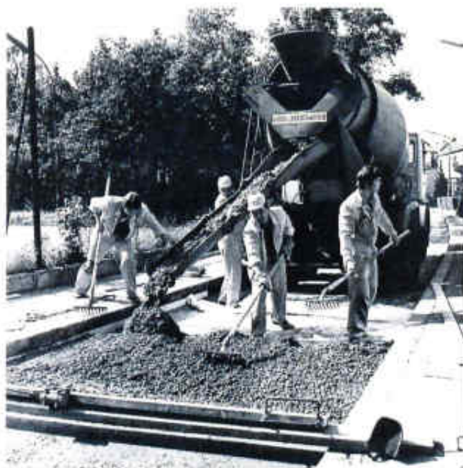
Straßenbau Beton Einsatz von Betonmischfahrzeugen
