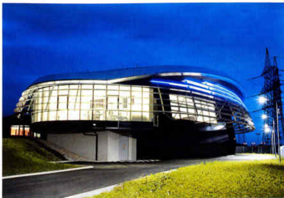
Schaltwarte für die Austrian Power Grid AG 2009 errichtet
