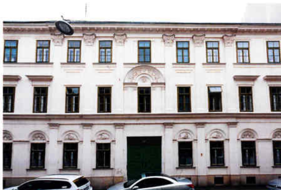
Franzenstraße Arbeiterquartier Fassade 1910/1911 originalgetreu restauriert
