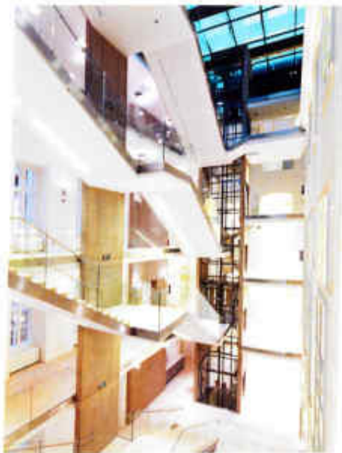
Moderne Aufschließung eines historischen Gebäudes: Sanierung des Winterpalais von Prinz Eugen in der Wiener Himmelstorgasse mittels eines neu errichteten zentralen Stiegenhauses als Zweckbau für das Finanzministerium.
