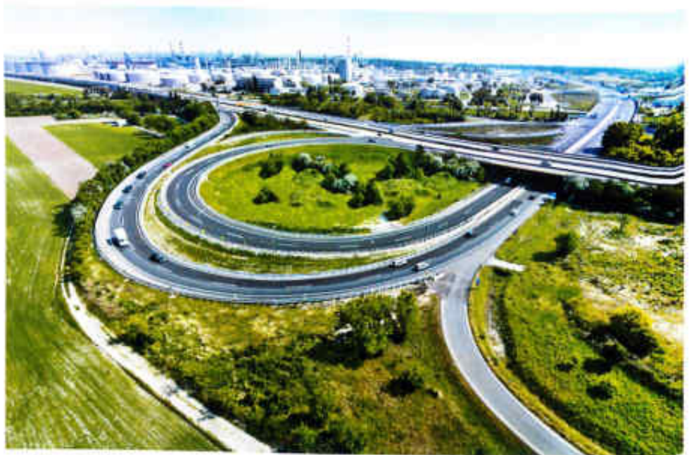
Die Auffahrtstampen der A4 (Knoten Schwwechat) wurden in vier Monaten bei unbeeinträchtigtem Straßenverkehr im Auftrag der ASFINAG verbreitert
