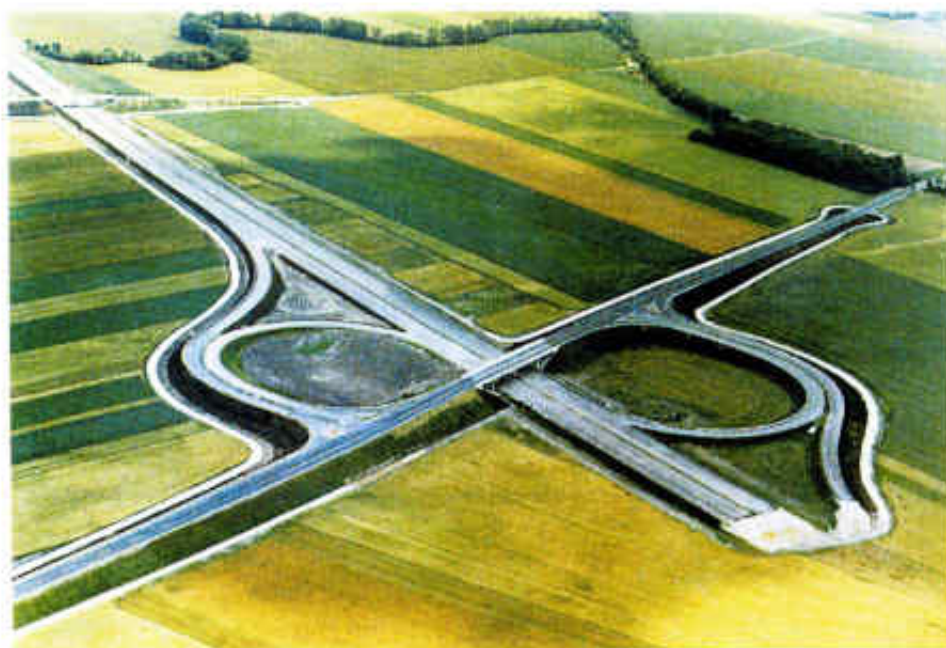
Bau der A3-Südostautobahn (Teilabschnitt Hornstein – Müllendorf)
