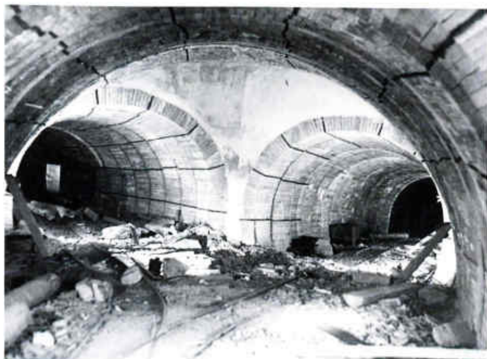
Industriebau Tschechoslowakei: Schachtbau
