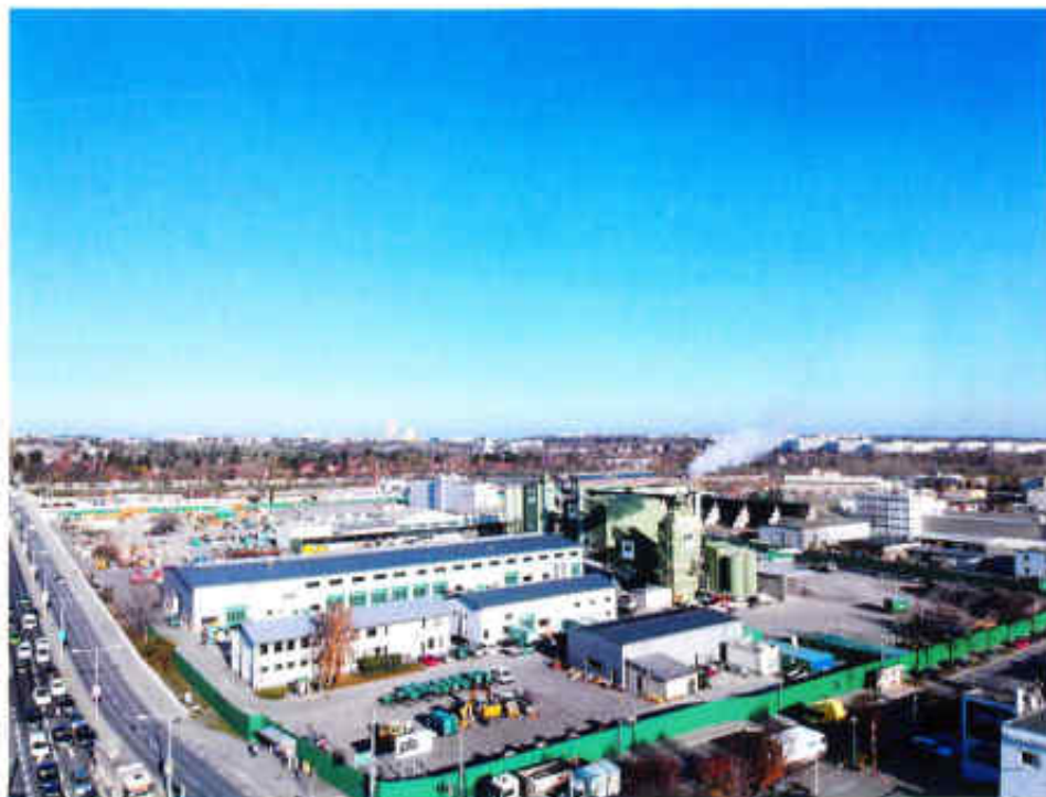
Bauhof Wien Inzersdorf, Ausdehnung 10 Hektar (Asphalt und Betonanlage, Werkstätten und Lagerhallen, Basissoffrecyclingbetrieb, seit 2019 Baugerätehandel und -verleih)
