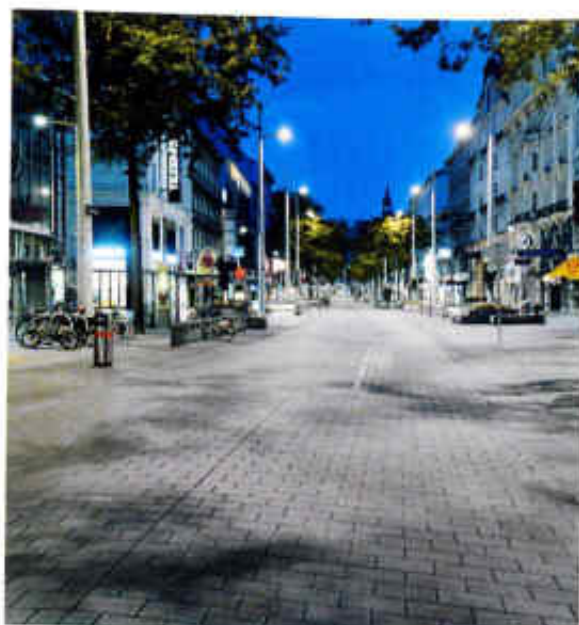
Umgestaltung der Mariahilfer Straße (Wien) zu einer Begegnungszone; Spezialausführung von Pflasterungen
