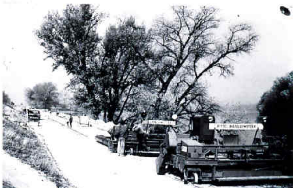
Straßenbau Asphalt Wien, Kaiser Mühlendamm
