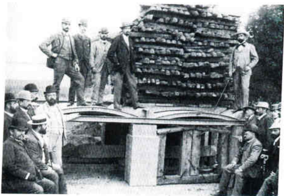
Belastungsprobe Stambetonbogen Bratislava, 1879
