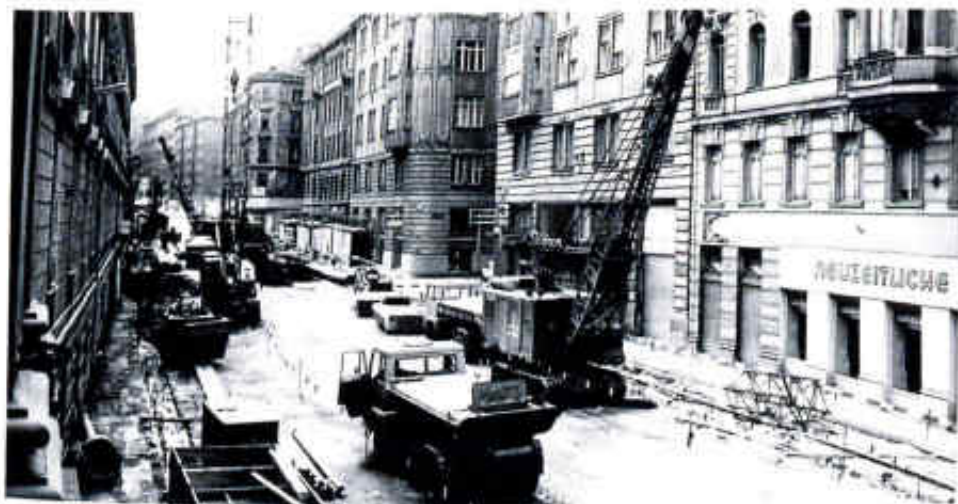
Wien, U1-Bau Baustabschnitt Favoritenstraße-Resselpark
