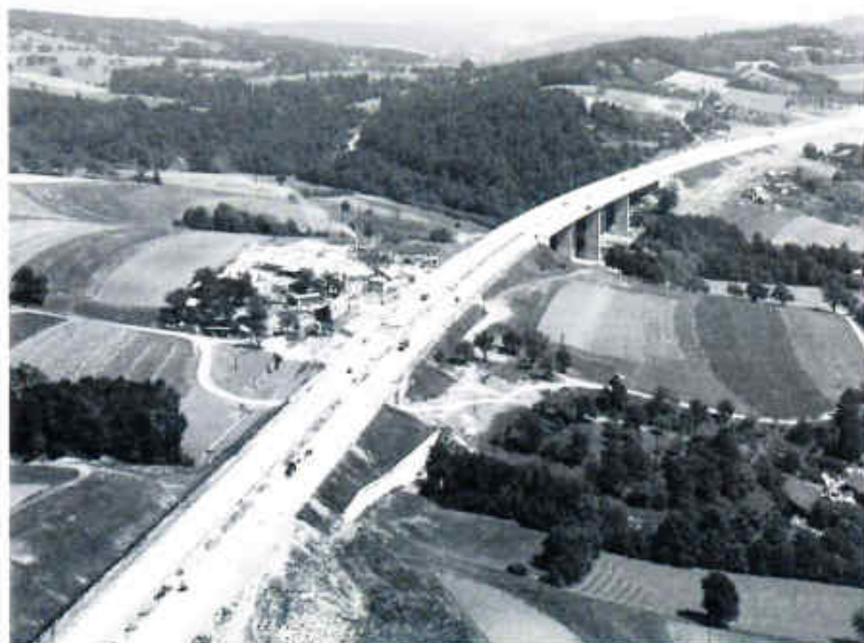
A1, Bandos Steinhäusl Betondecke 1957/1958 hergestellt
