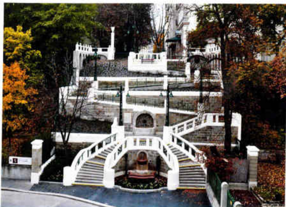
Revitalisierung historischer Bauwerke: Instandsetzung der 1910 errichteten Strudelhofstiege im 9. Bezirk in Wien.
