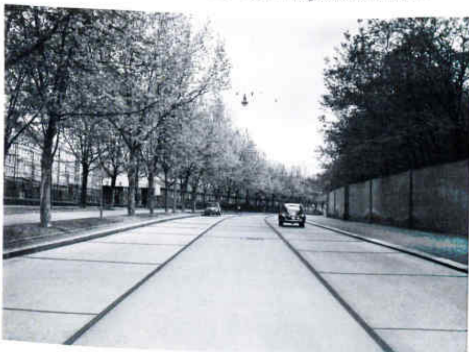
Wien, Währinger Gürtel, 1955
