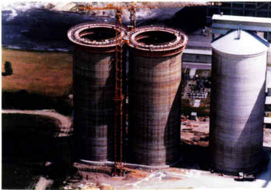
1994 Zwerntürmige Klinkersiloanlage mit Fassungsvermögen von je 25.000 t für die Perlmutter Zementwerke in Mannersdorf am Leithagebirge errichtet
