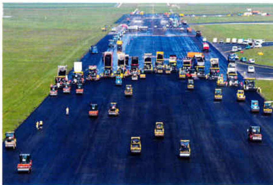
Pistenanierung Flughafen Wien 2016: Start- und Landebahn sowie die Rollwege an vier Wochenenden und in fünfundzwanzig Nächten bei Sicherstellung des Flugverkehrs ab 7 Uhr früh erneuert.
