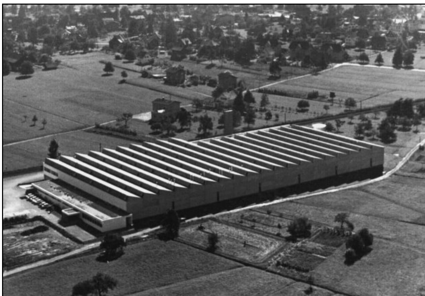
Abbildung 19: Werk II der Zumtobel KG kurz vor der Fertigstellung im Jahr 1970.
