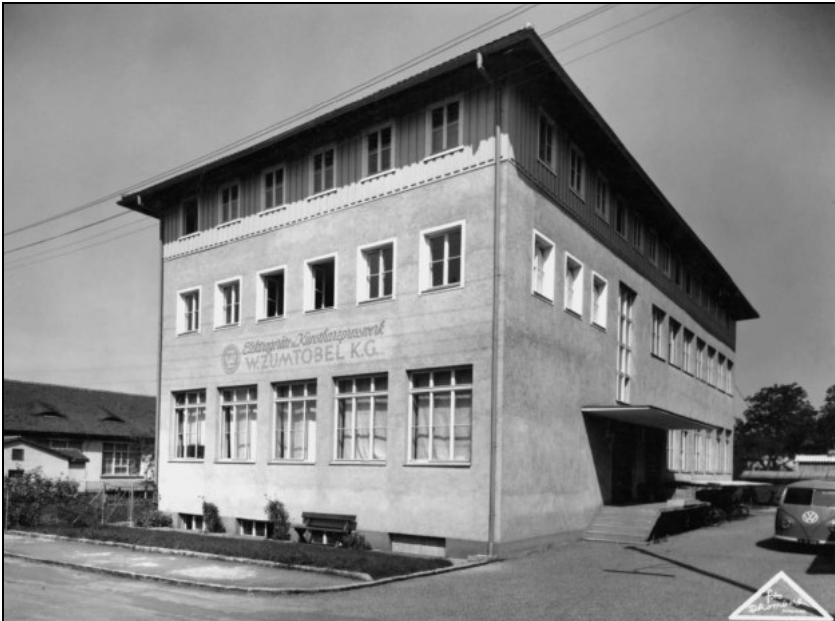
Abbildung 7: Das erste Fabriksgebäude der Firma Elektrogeräte und Kunstharzpresswerk W. Zumtobel KG in der Dornbirner Höchster Straße, fertiggestellt im Mai 1951. Zuvor befand sich das Unternehmen in angemieteten Räumen einer ehemaligen Schuhfabrik, erkennbar am linken Bildrand.
