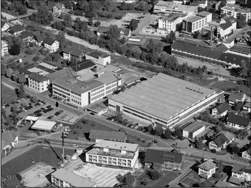
Abbildung 30: Werk I in der Dornbirner Höchster Straße. Nach Abschluss der Umbau- und Sanierungsarbeiten im Werksbereich I präsentierte sich der Unternehmensstammsitz im wesentlichen in seinem heutigen Erscheinungsbild.
