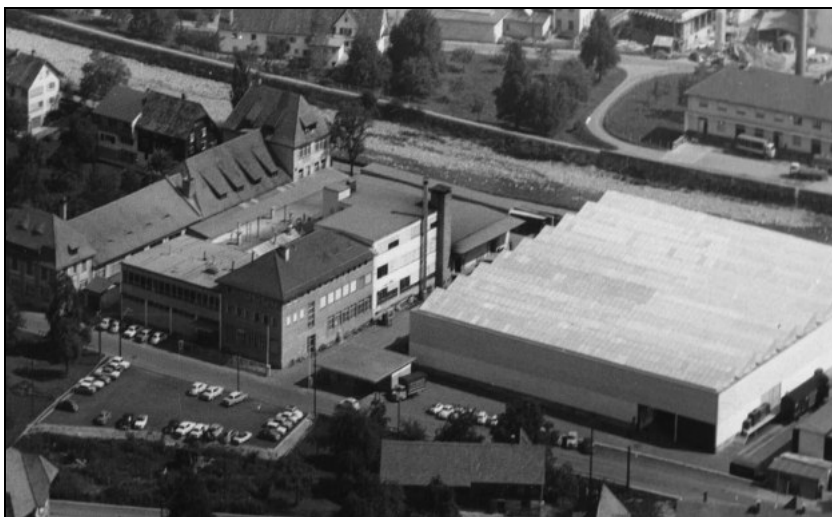
Abbildung 18: Standort Dornbirn, Höchster Straße: In der Mitte das erste Firmengebäude aus dem Jahr 1950. Deutlich erkennbar sind die etappenweise erfolgten Anbauten. Mit dem Bau einer Shedhalle (rechts) im Jahr 1965 waren die Platzressourcen rund um das ursprüngliche Betriebsgebäude weitgehend ausgeschöpft.
