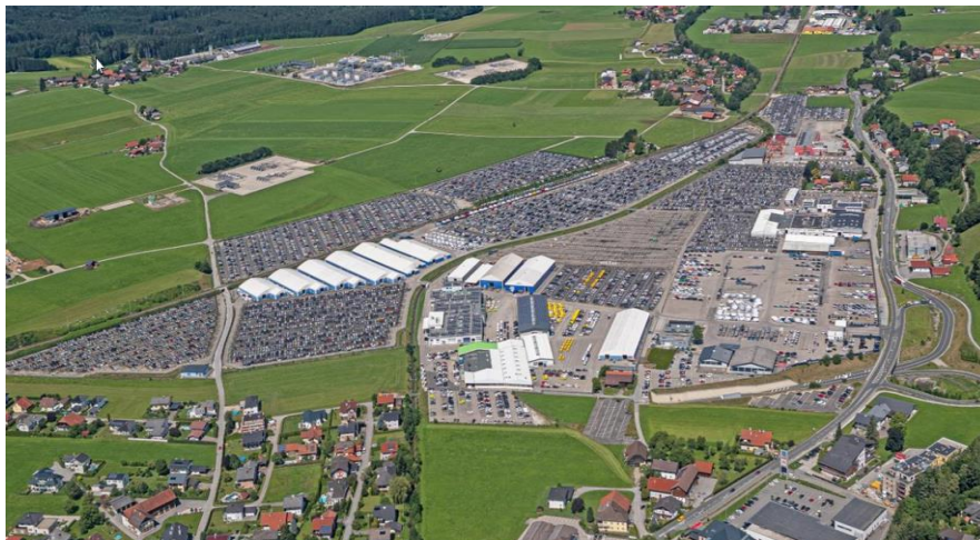
Autolagerflächen in Straßwalchen
