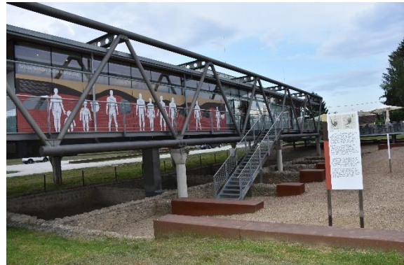
Bild 7: Das Pavillonsgebäude und das Freigelände Flavia Solva. © UMJIAArchMk.
