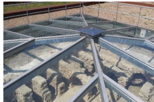
Bild 4: Fußbodenheizung in Flavia Solva. © UMJ/ AArchMk.
