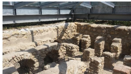
Bild 3: Fußbodenheizung (Hypokaustum) in Flavia Solva. © UM/JIAArchMk.
