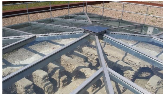
Bild 4: Fußbodenheizung in Flavia Solva. © UM/JIAArchMk.
