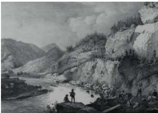
Bild 10: Sprengarbeiten für einen Eisenbahnbau.
