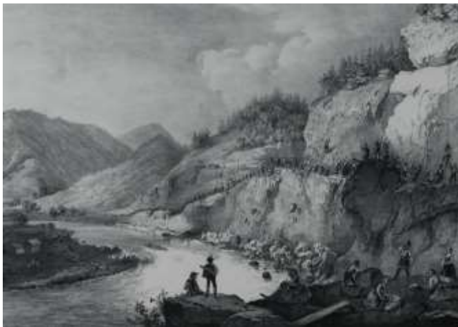
Bild 10: Sprengarbeiten für einen Eisenbahnbau.
