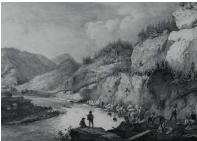
Bild 10: Sprengarbeiten für einen Eisenbahnbau.
