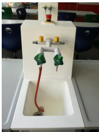
Abbildung 22 – Armatur eines Arbeitsplatzes für Lernende von Vorne, mit Waschbecken und Gasanschluss. Foto: Böhm
