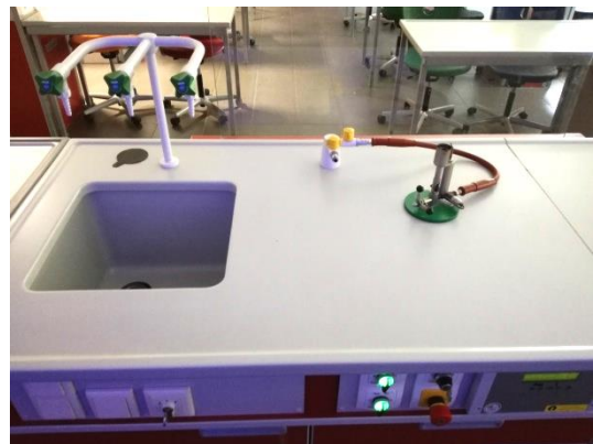
Abbildung 20 - Demonstrationstisch mit Gas- und Wasseranschluss. Foto: Böhm
