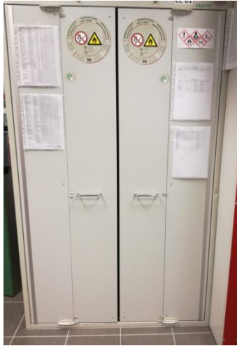
Abbildung 6 - Sicherheitsschrank Typ 90 geschlossen. Foto: Böhm
