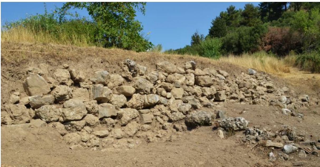
Terrassenmauer an der Ostseite des Südsporns des Stadthügels
