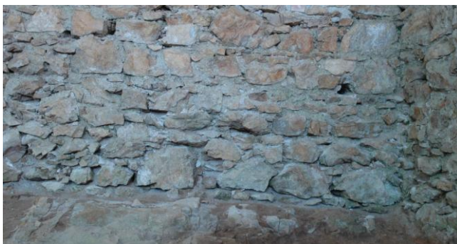
Abb.2: Mauerwerk der Südwand, Südwestecke. Foto J. Kraschitzer
