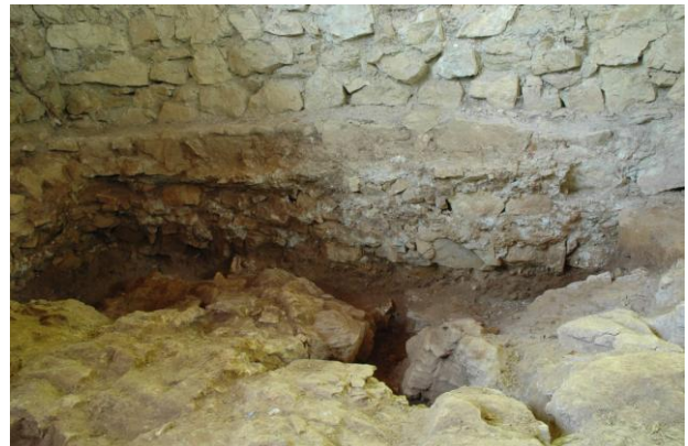
Abb. 8: Fundament der Palas-Nordmauer im Lehm Bef. 28. Foto J. Kraschitzer.
