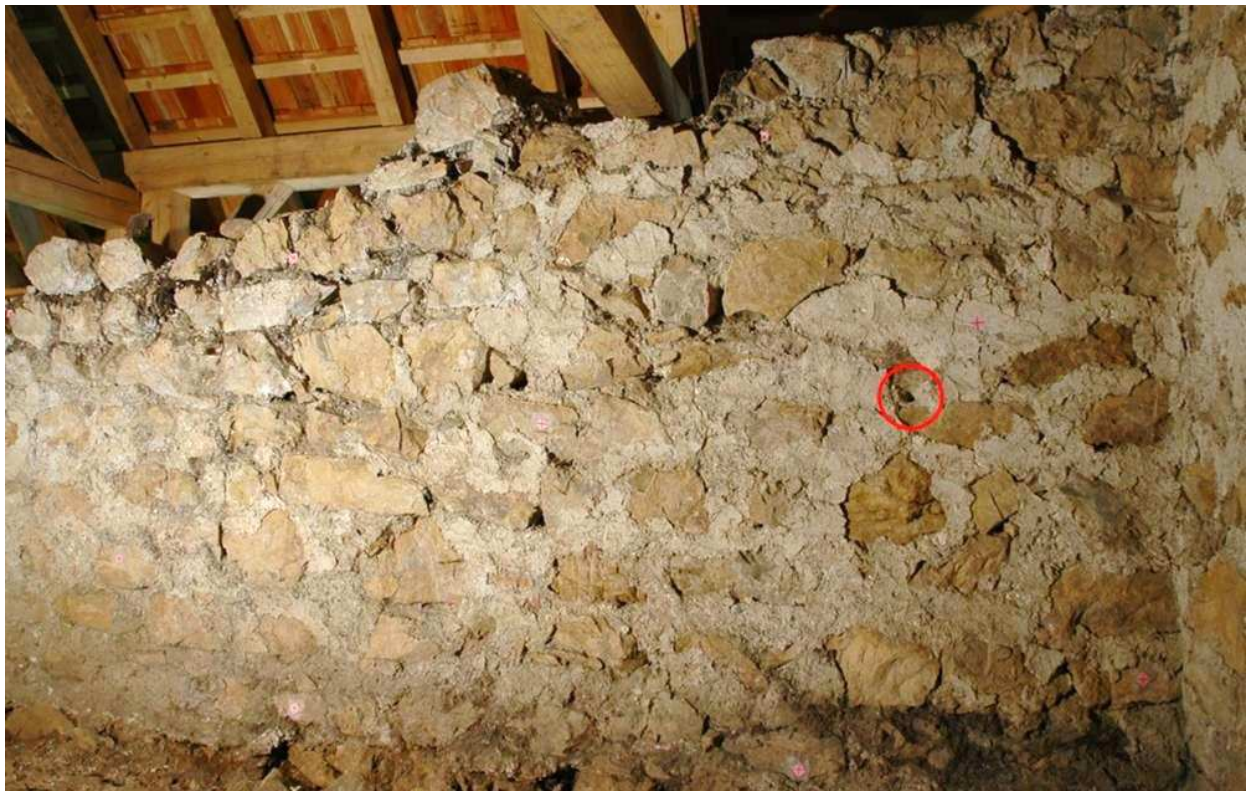
Turne, Bergfried, Westwand innen mit Verputzresten und Dübelloch (Foto J. Kraschitzer).
