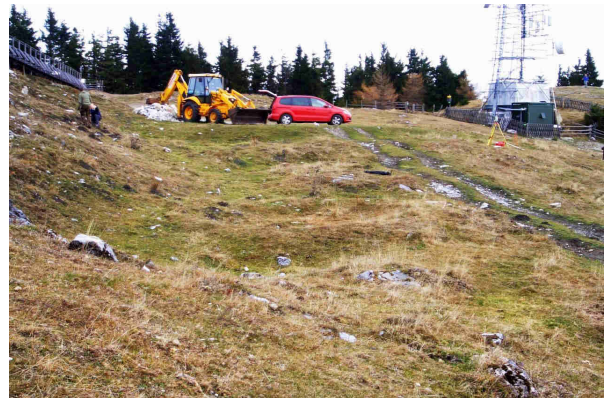
Tract A, „Gebäudeterrasse“, von Südwesten.
