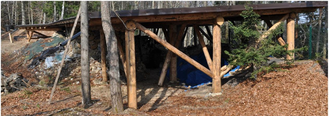
Abb.1: 2014 partiell neu errichteter und insgesamt neu eingedeckter Schutzbau über Palas und Backofen, von Osten (Foto BDA, J. Fűrnholzer).
