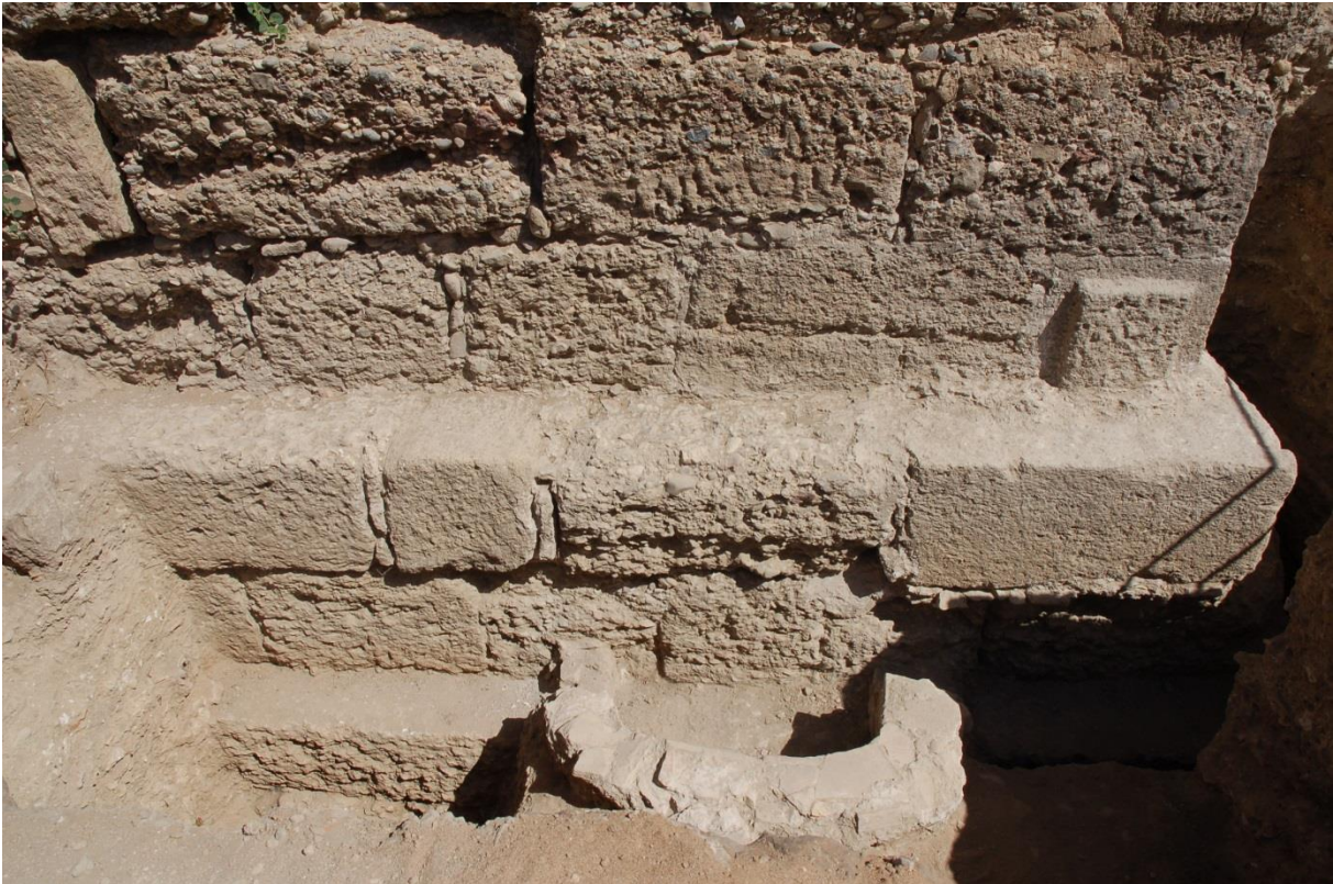
Maueransicht von Raum B – Westwand in Sondage B
