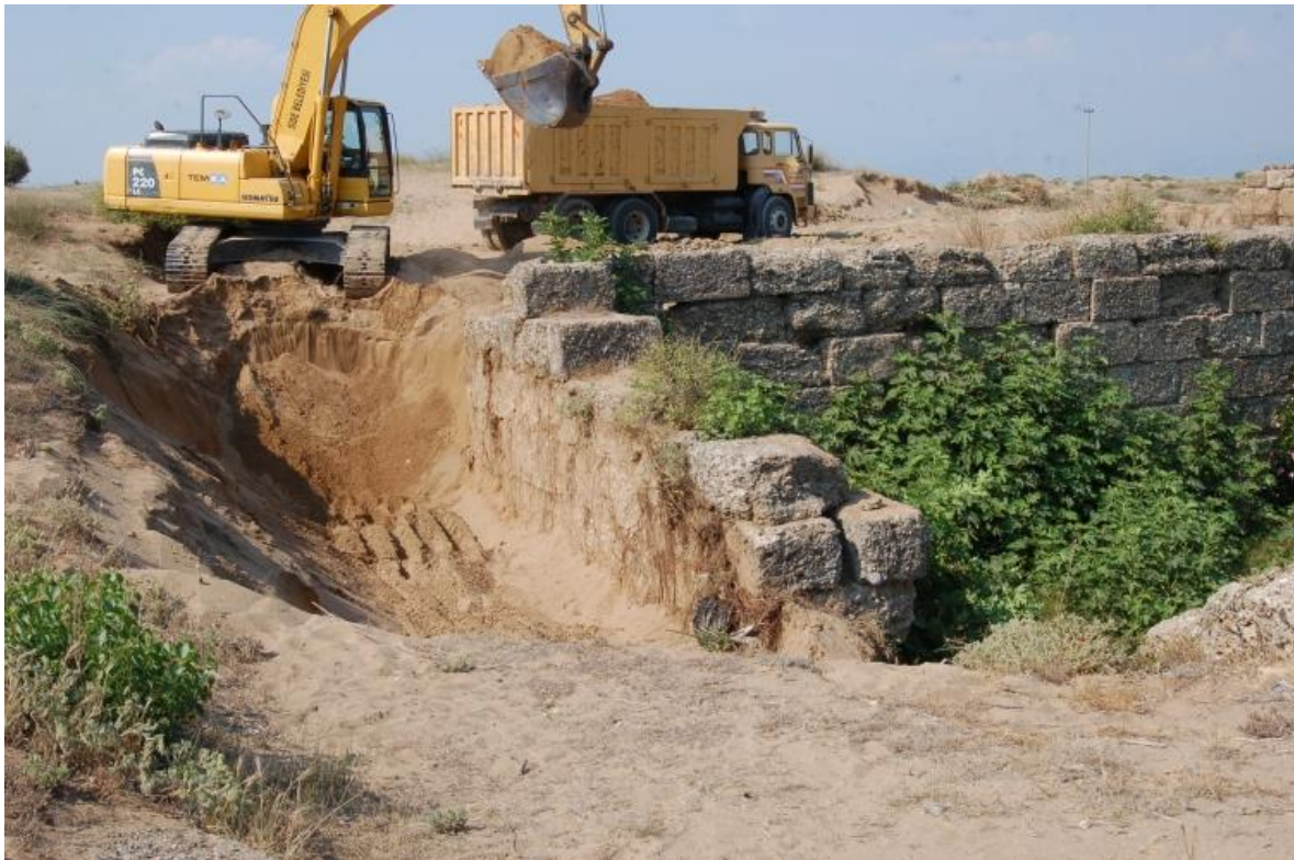
Abb. 1: Entfernen des Sandes durch den Bagger außerhalb der Nordwestecke des Torhofes (Foto Univ. Graz)
