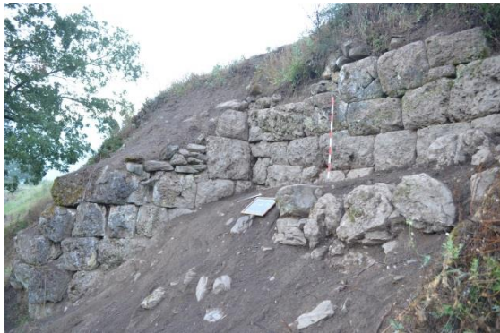
Abb. 4: Außenschale und Turm 5 von Westen
