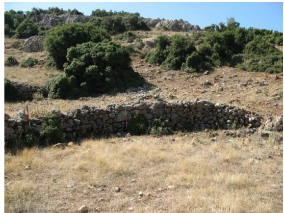
Abb. 18: Terrassenmauer im Süden
