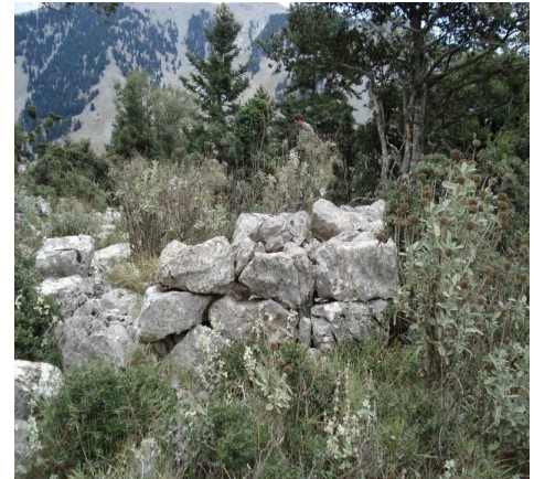
Abb. 16: Mauerzug (Gebäude A) von Südosten
