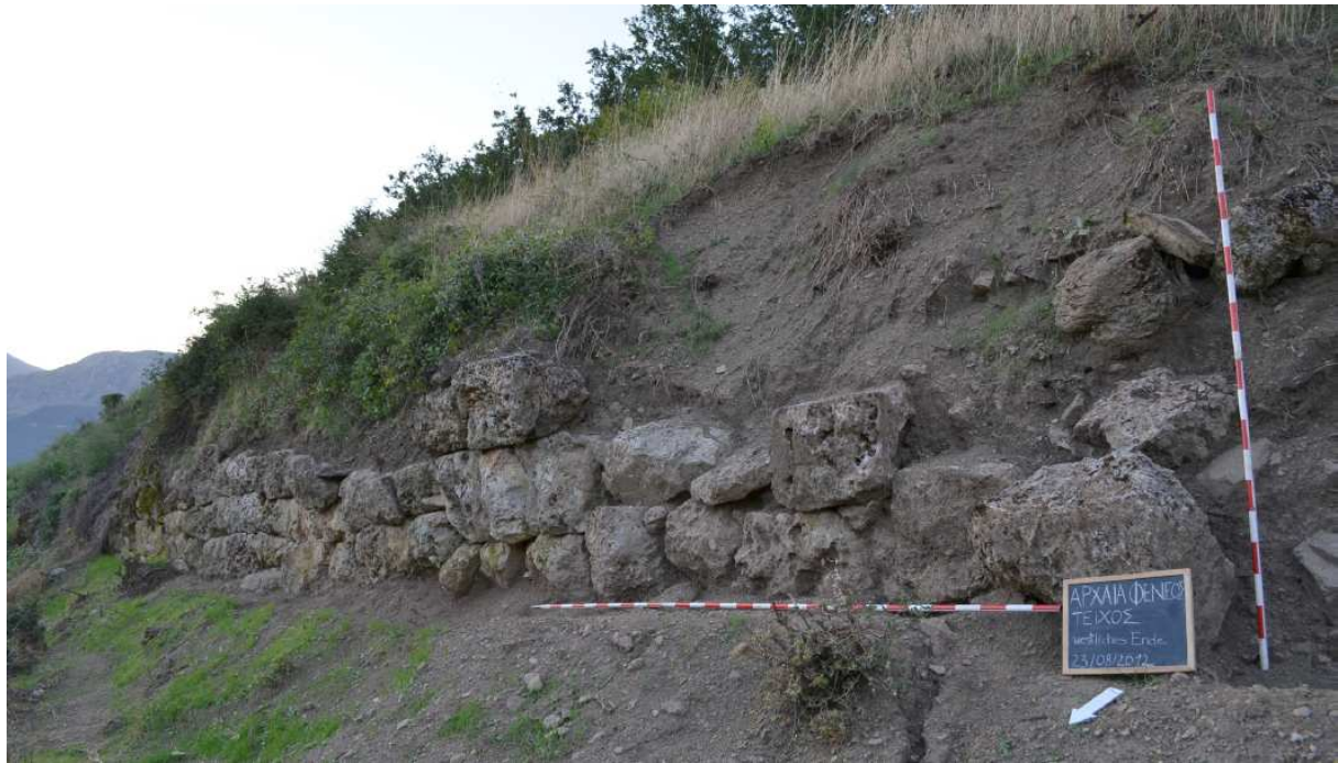
Abb. 4: Maueransicht, westliches Ende, von Norden
