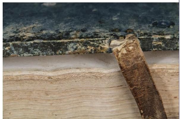
© Uni Graz / Restaurierung
