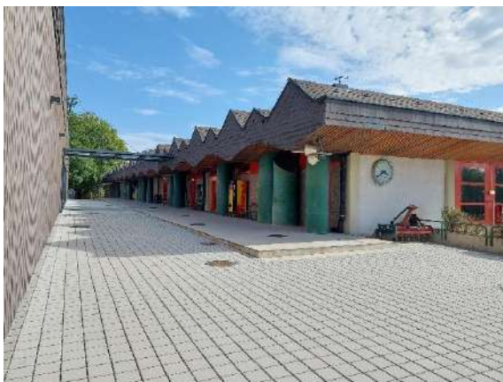
Abbildung 339: Zufahrt zwischen den Gebäuden.
