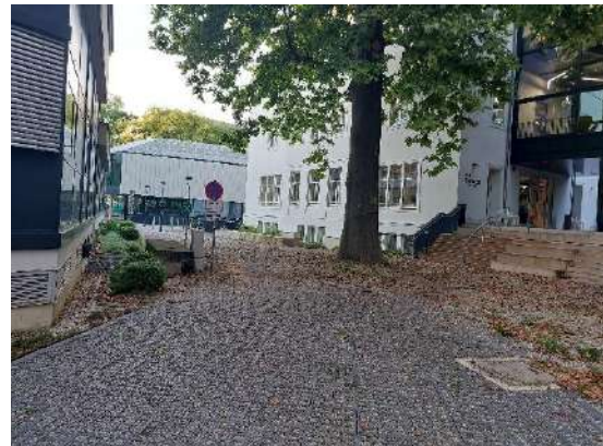
Abbildung 147: Innenhof mit Rasengittersteinen und Schotter.
