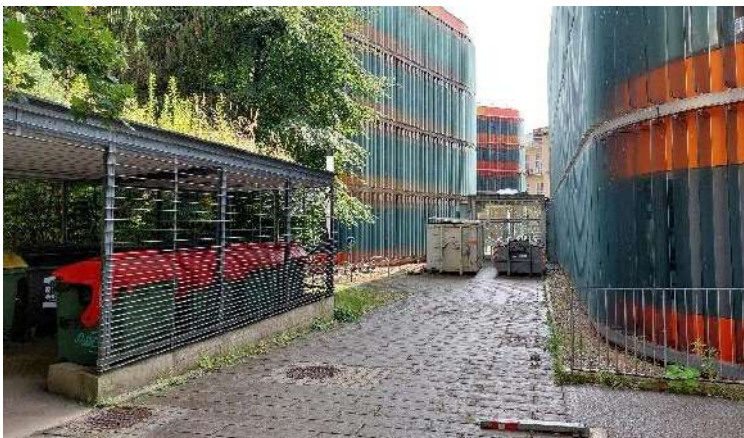
Abbildung 253: Müllplatz mit Dachbegrünung beim Zufahrtsweg von der Humboldtstraße.
