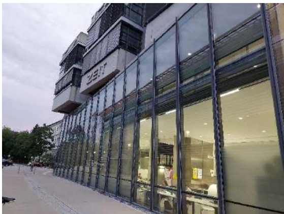
Abbildung 64: Glasfront an der Ostseite des Gebäudes.
