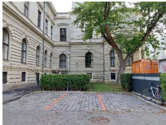
Abbildung 73: Müll- bzw. Containerabstellplatz.
