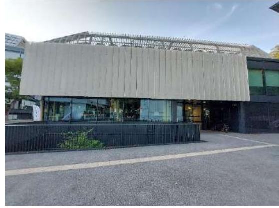
Abbildung 155: Rückseite mit Gebäudegraben.
