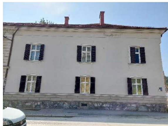
Abbildung 118: Seitliche Fassade in Richtung Halbärthgasse.
