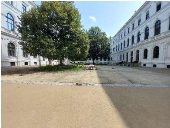
Abbildung 58: versiegelter Innenhof mit Bauminselfn mit Unterwuchs.
