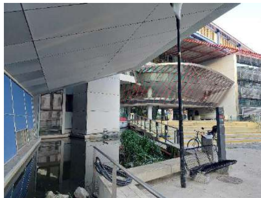
Abbildung 95: technisch umgesetztes Stillgewässer (Retentionsbecken) beim Eingangsbereich.
