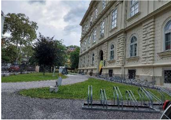
Abbildung 275: Bereich des Haupteinganges.
