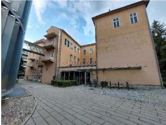
Abbildung 238: Rückseite mit dem Flachdachbereich und der Heckeninsel vor dem Hintereingang.
