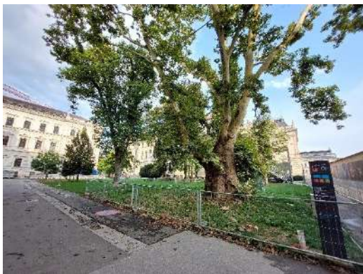
Abbildung 78: Aufgrund der Baustellentätigkeiten eingezäunter Wiesenbereich.
