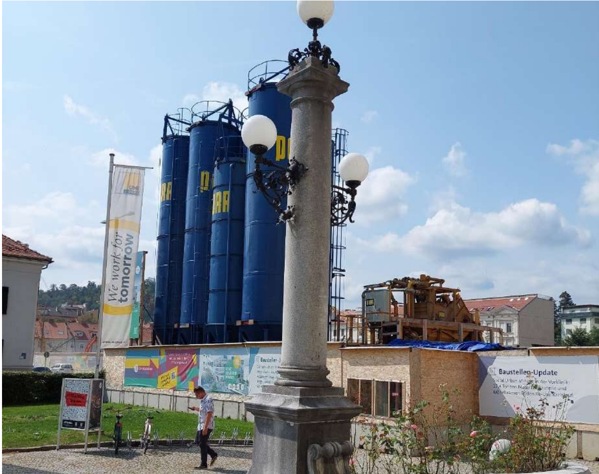
Abbildung 115: Sicht auf die Baustelle Richtung Westen.
