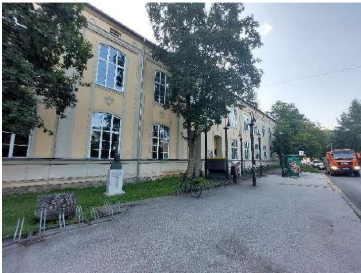
Abbildung 300: Eingangsbereich mit Vorplatz und alten Leuchtquellen.
