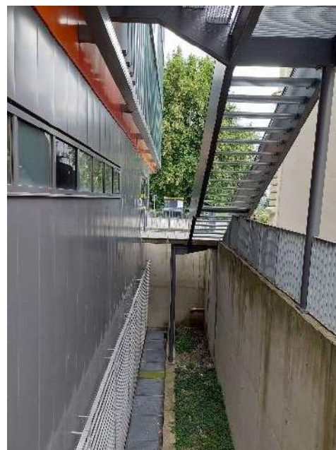
Abbildung 246: Gebäudegraben zum Teil begrünt.
