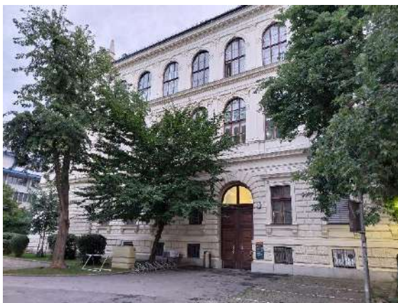
Abbildung 50: westlicher Eingang des Gebäudes mit Parkplatzbereich und Bäumen.
