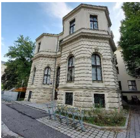
Abbildung 74: Rosensträucher entlang der nördlichen Fassade.
