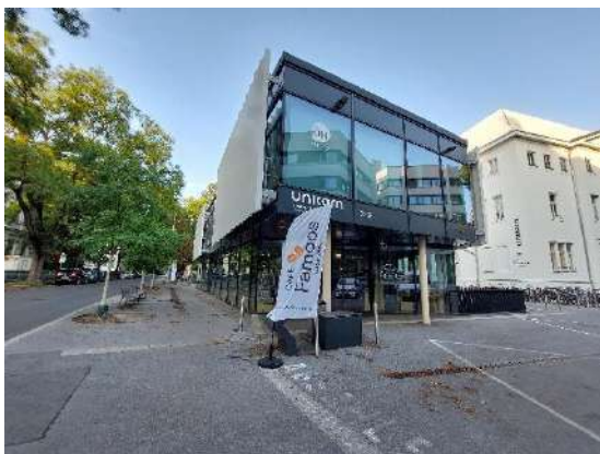
Abbildung 152: Fassade zum Parkplatz bzw. Schubertstraße gerichtet mit großen Glasfronten.
