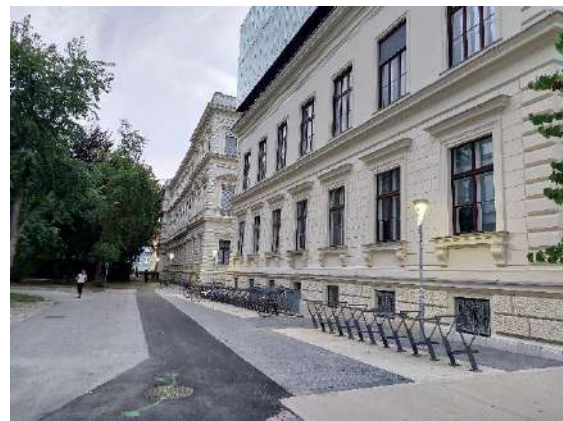
Abbildung 65: Zufahrt und Parkplätze an der Ostseite mit offenen Radabstellplätzen.
