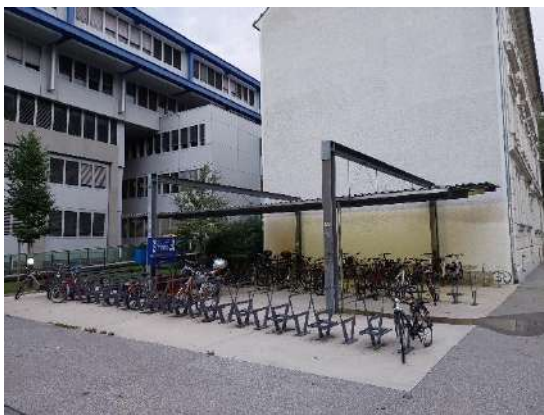
Abbildung 102: großer zum Großteil überdachter Radabstellplatz.
