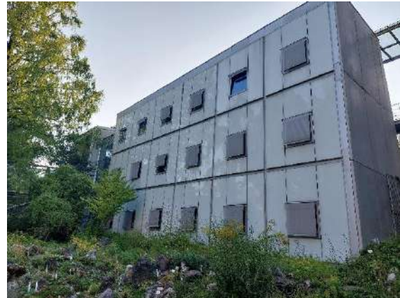
Abbildung 214: Vordere Fassade mit dem Steingarten davor.
