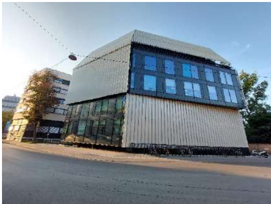
Abbildung 146: Fassade in Richtung Schubertstraße.
