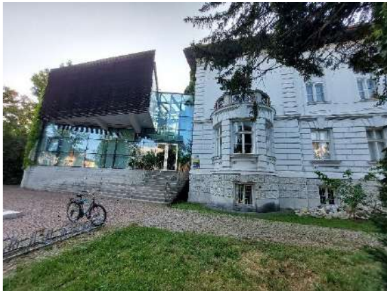
Abbildung 209: Eingangsbereich mit großem Vorplatz.
