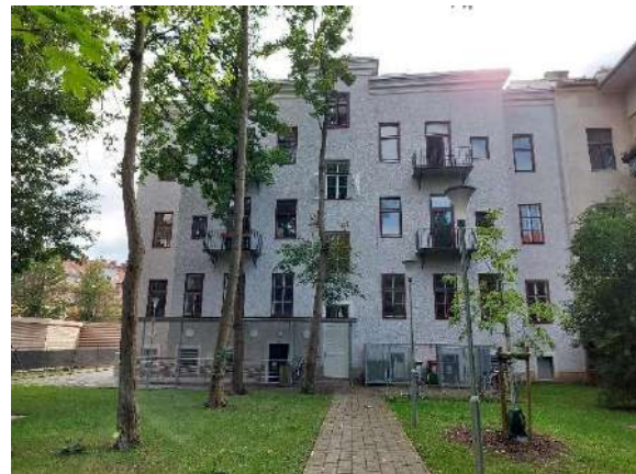
Abbildung 266: Gebäuderückseite mit dem großen Hinterhof.
