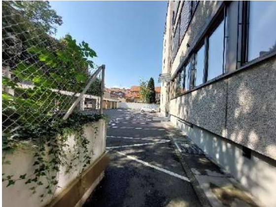
Abbildung 169: Parkplatzfläche an der Gebäude- rückseite.
