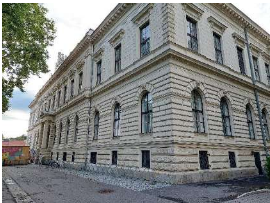
Abbildung 72: Bereich des Haupteingangs des Universitätsplatz 5.
