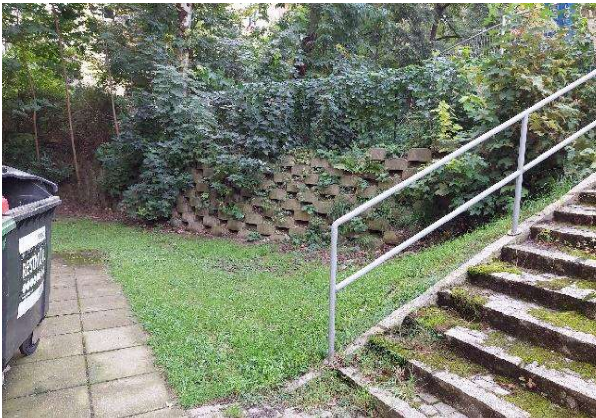
Abbildung 114: technisch gestaltete Steinmauer mit Bepflanzung.
