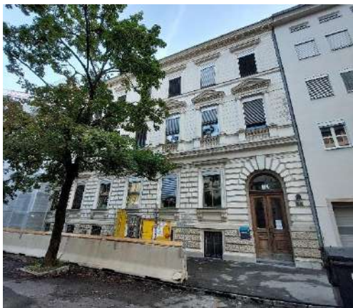
Abbildung 86: Eingangsbereich des Objekts.
