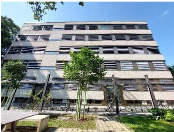
Abbildung 165: Fassade in Richtung Innenhof.
