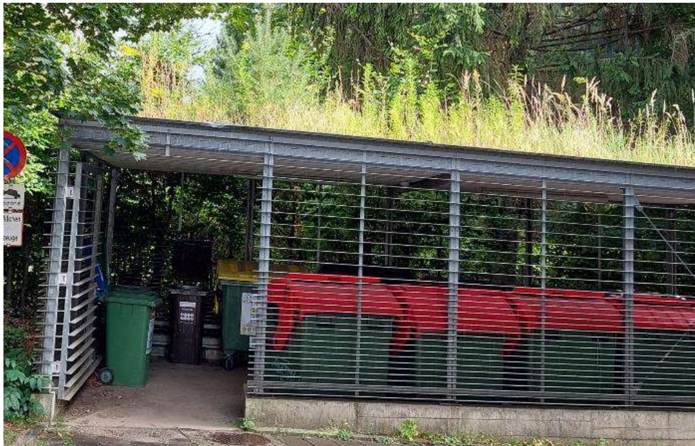
Abbildung 23: Extensive Dachbegrünung (oben), nährstoffreichere Begrünung (unten).
