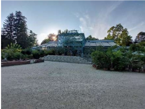
Abbildung 217: historisches, neu saniertes Glashaus mit geschottertem Vorplatz.
