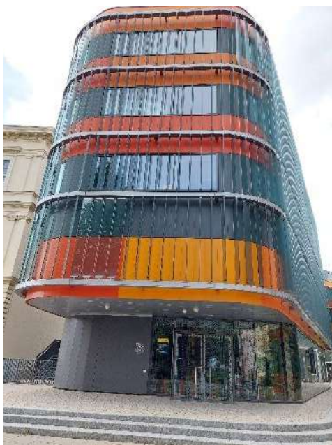
Abbildung 245: Eingangsbereich zum Erdgeschoss und der Lernzone.
