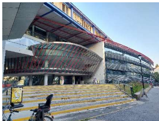
Abbildung 97: Haupteingangsbereich des Gebäudes mit dem versiegelten Vorplatz und Treppenzugang.
