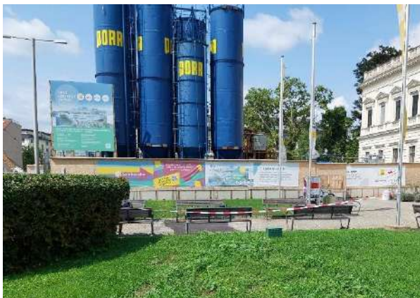
Abbildung 112: Sicht auf die Baustelle Richtung Campus.
