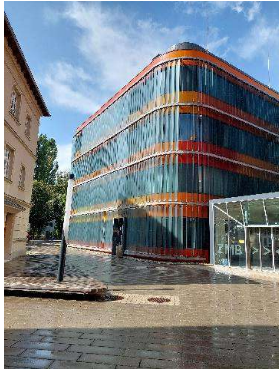
Abbildung 255: Fassade der Adresse Humboldtstraße 46.
