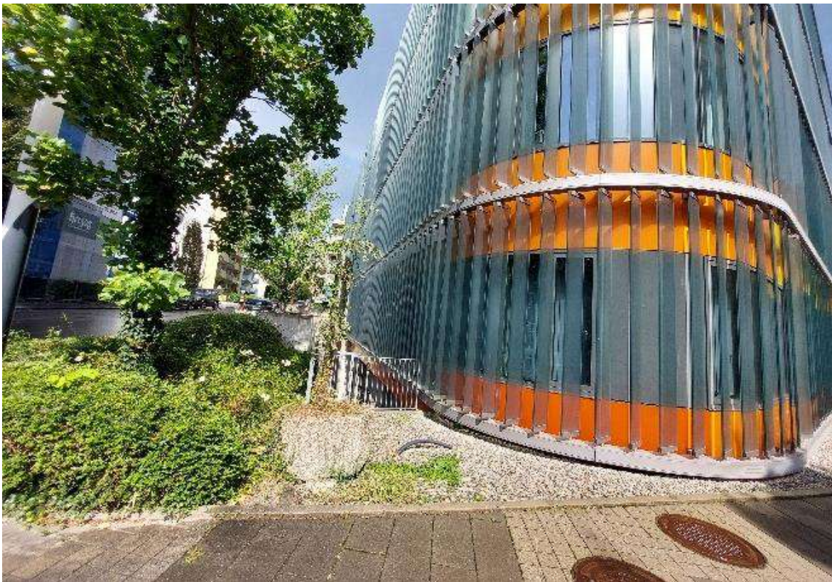
Abbildung 256: Bauminself mit Heckenunterwuchs und einem Pflanztrof bei der Zufahrt zur Humboldtstraße 46.
