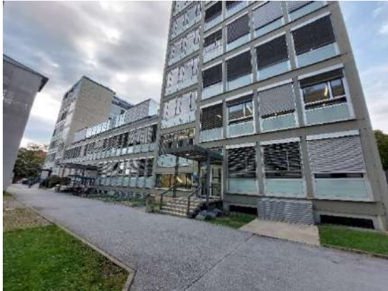
Abbildung 133: Eingangsbereich mit Flachdächern.
