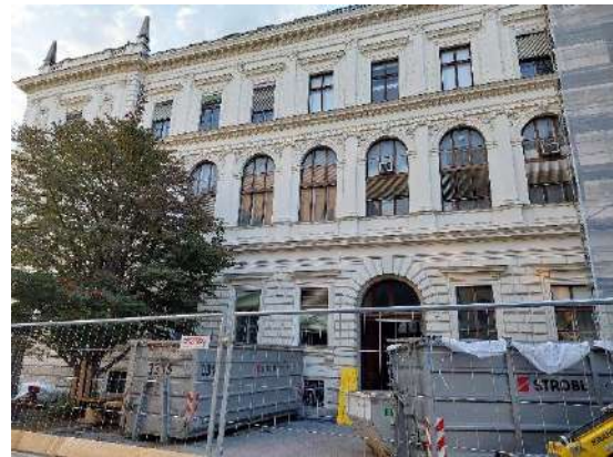
Abbildung 71: östlicher Eingangsbereich mit Parkplätzen bevor.
