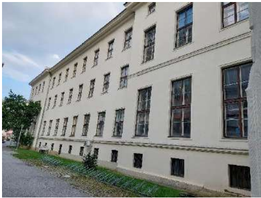
Abbildung 76: Hinterseite des Gebäudes.
