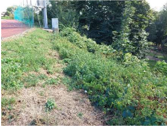
Abbildung 329: verbrachte Böschung zum Rosenhain führend, mit Neophyten und Mähgutablagerung.
