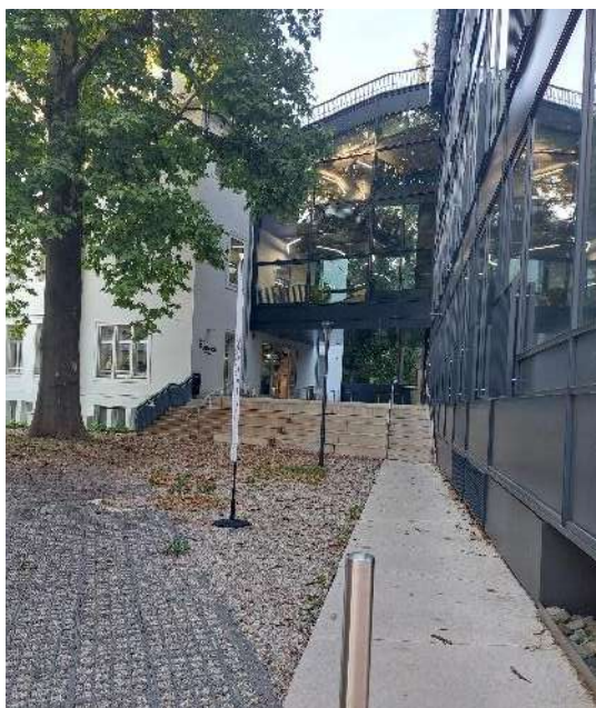
Abbildung 148: Ein- bzw. Zugangsbereich.
