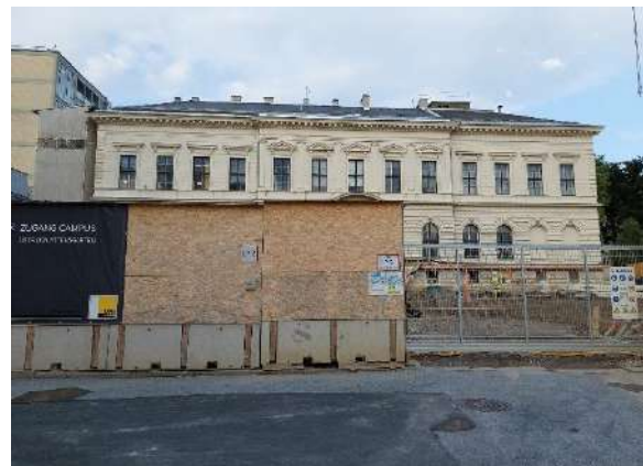
Abbildung 116: Baustelleneinfahrt in der Attemsgasse.
