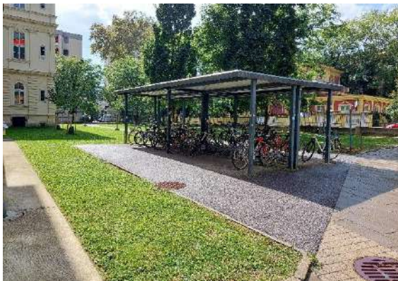
Abbildung 279: Metall überdachter Fahrradabstellplatz.
