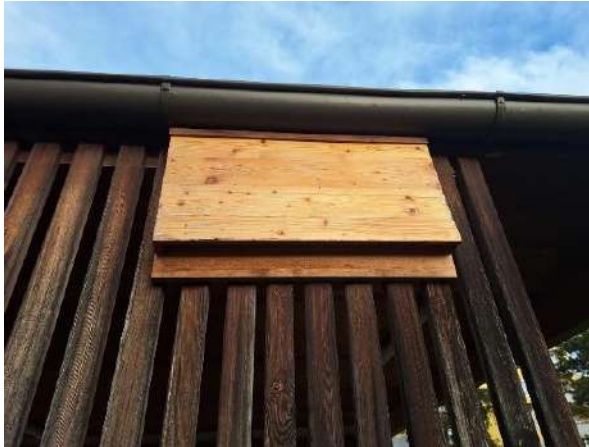
Abbildung 7: Fledermauskasten an der Hauswand.
