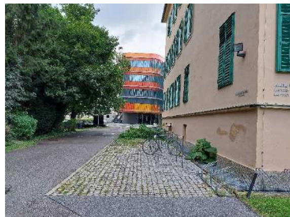
Abbildung 237: asphaltierter Zufahrtsweg und gepflasterte Radabstellplätze.
