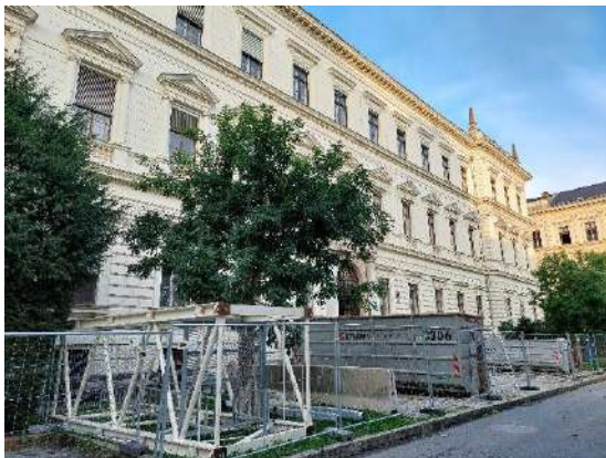
Abbildung 68: westlicher Eingangsbereich des Universitätsplatz 4 (aktuelle Baustelle).
