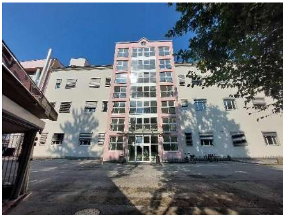
Abbildung 304: Gebäuderückseite mit versiegeltem Parkplatz.
