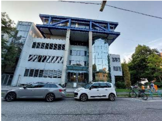
Abbildung 88: Eingangsbereich an der Schubertstraße.
