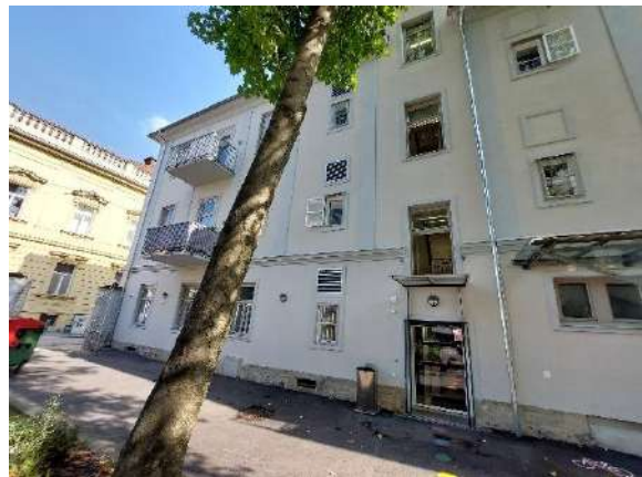
Abbildung 184: Innenhof mit versiegeltem Zufahrtsweg.
