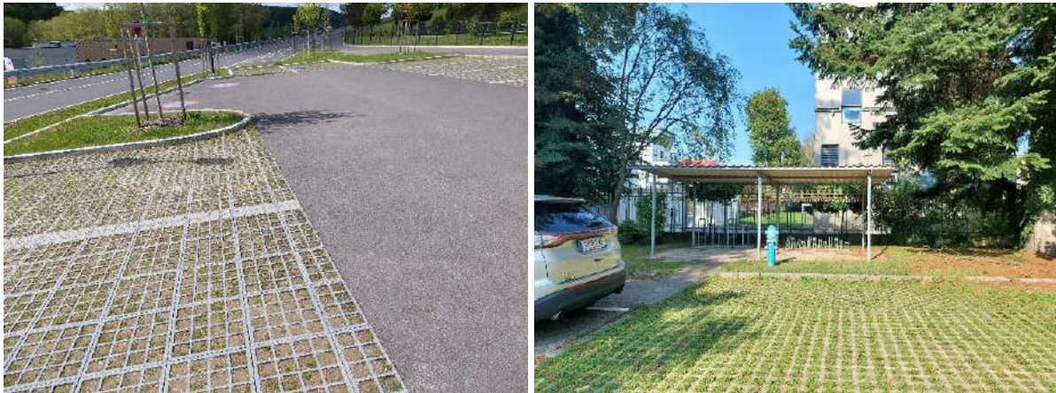
Abbildung 26: Kunststoffrasengitter kurz nach der Errichtung (links), Betonrasengittersteine mit Bewuchs (rechts).
