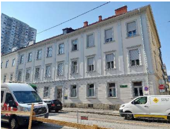
Abbildung 183: Außenfassade Richtung Elisabethstraße.
