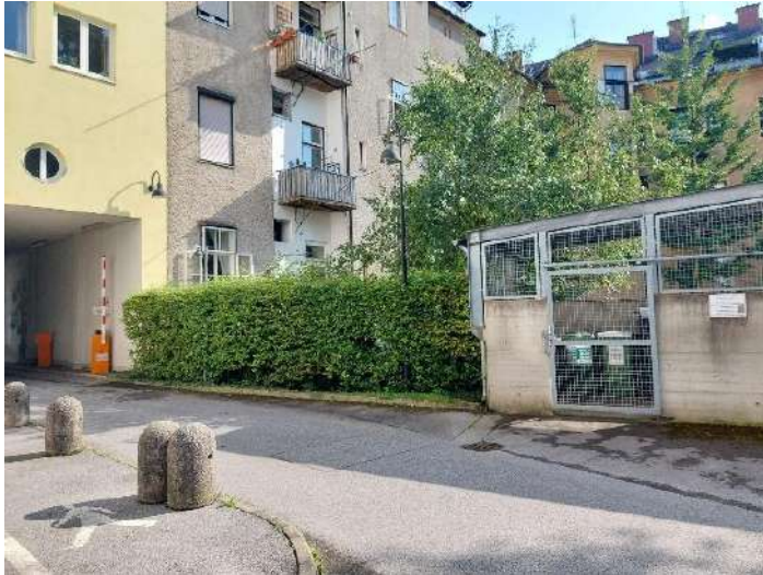
Abbildung 308: überdachte Müllinsel mit anschließender Hainbuchenhecke und alten Beleuchtungsquellen.
