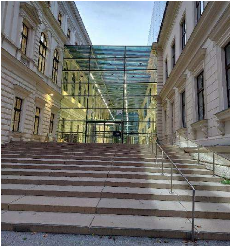
Abbildung 66: südlicher Eingangsbereich von Universitätsplatz 3a.
