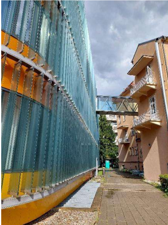
Abbildung 249: Verbindungsgang zwischen Humboldtstraße 50 und Heinrichstraße 31.
