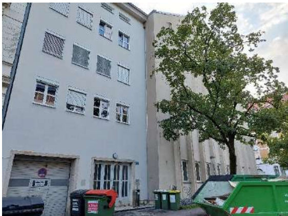
Abbildung 84: Hintere Seite des Gebäudes mit asphaltierten Gehwegen, Parkplätzen und Zufahrten.
