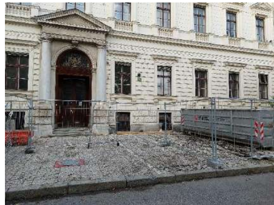
Abbildung 69: versiegelter Vorplatz in Konstruktion.
