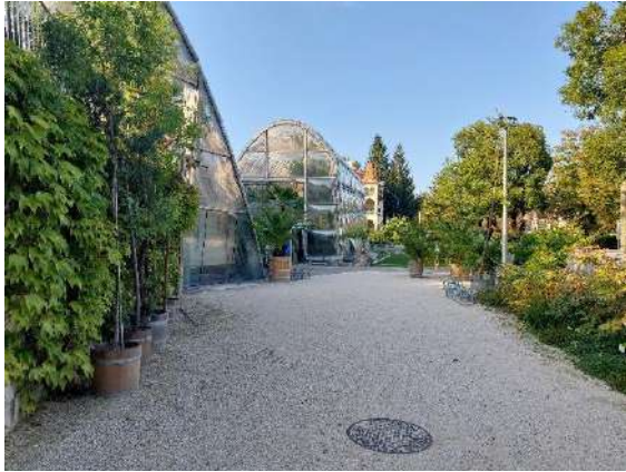
Abbildung 223: Haupteingang des Glashauses mit großem Vorplatz.
