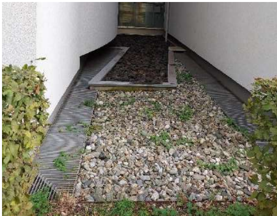
Abbildung 143: Geschotterte Nischen für Regenwasserauffang.
