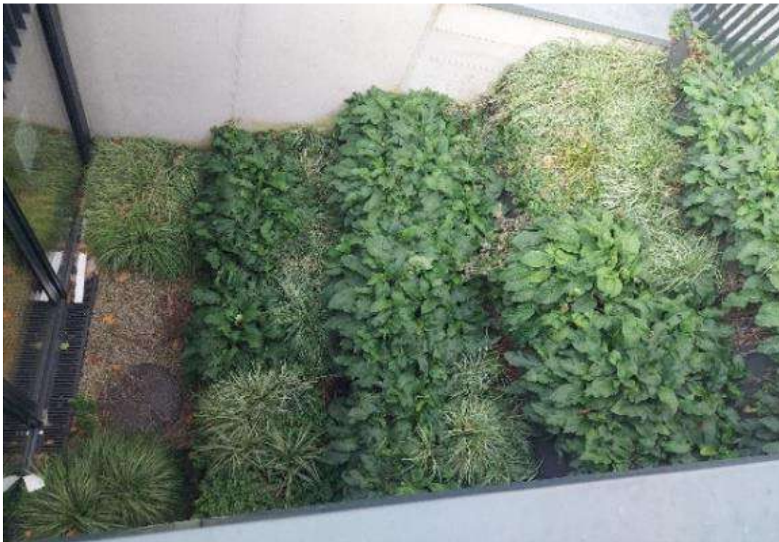
Abbildung 163: Begrünter, stufenartiger Gebäudegraben.
