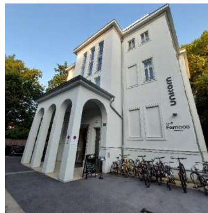
Abbildung 158: Eingangsbereich mit Flachdach.
