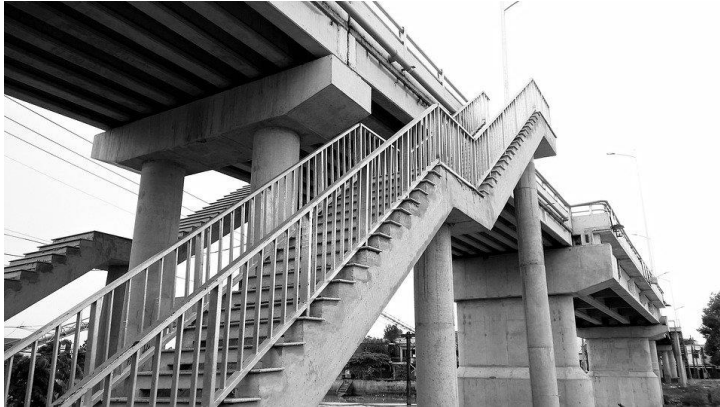
Bild 2: Beton. © Pixabay. Bildquelle: https://cdn.pixabay.com/photo/2016/08/14/21/52/bridge-1594111_960_720.jpg (10.03.2021)
