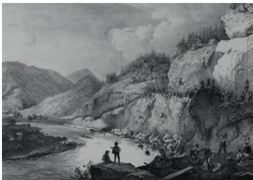
Bild 10: Sprengarbeiten für einen Eisenbahnbau.
