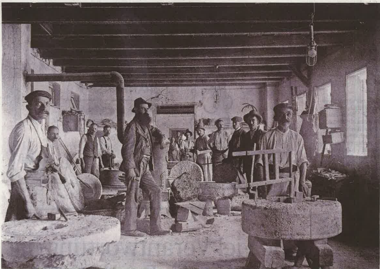
Nach dem Herausbrechen im Steinbruch wurden die Mülhsteine in der Werkstatt zurechtgehauen. Aufnahme aus Perg, 1910.
