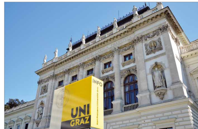
Hauptgebäude © Universität Graz
