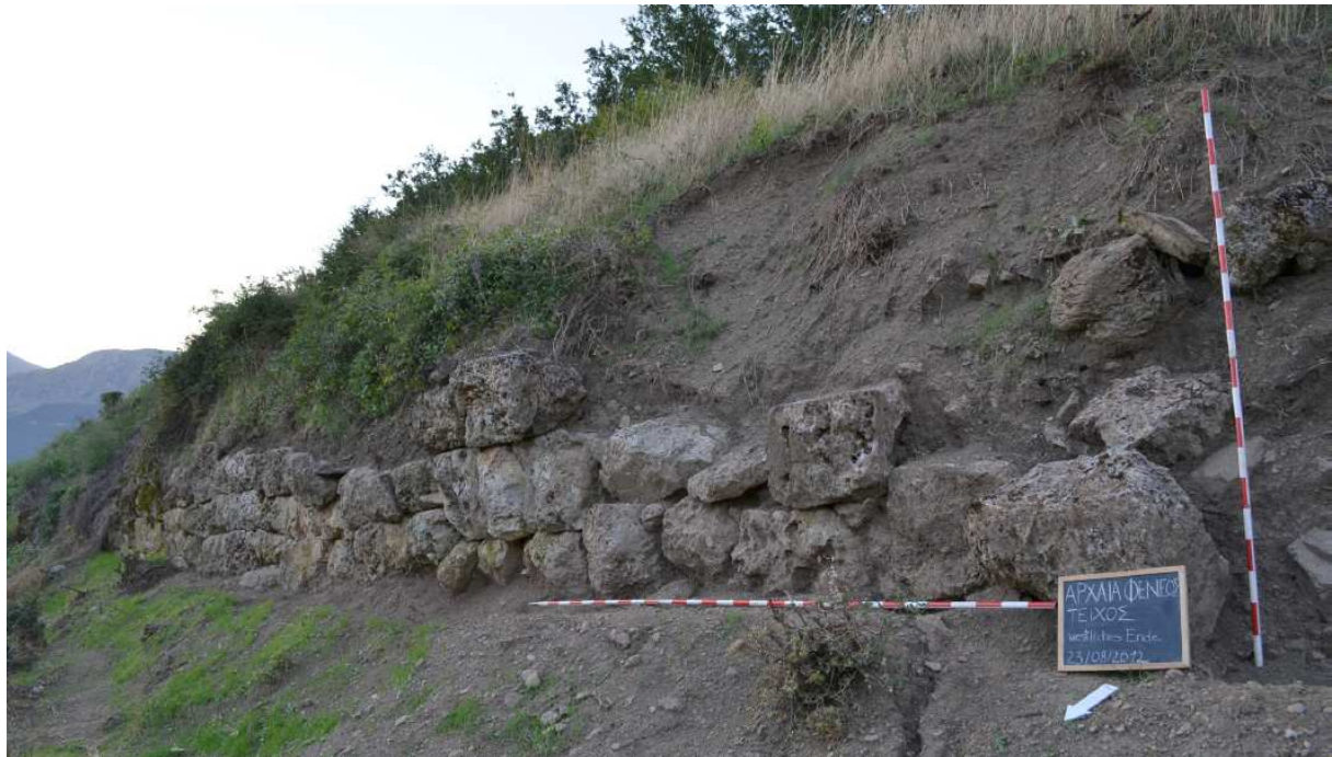
Abb. 4: Maueransicht, westliches Ende, von Norden
